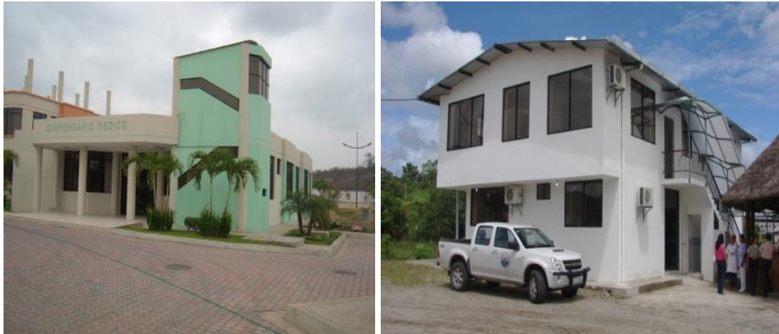
Ilustración 5. Centros de Primer Nivel
