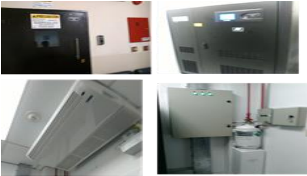
Ilustración 9. Área RX remodelada
