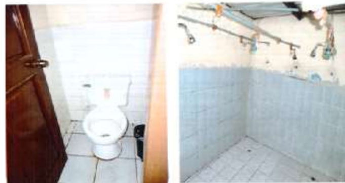
FOTOS LUEGO DE HABER REALIZADO LOS TRABAJOS DE MANTENIMIENTO
